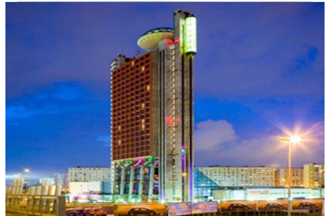
Hotel Hesperia Tower Barcelona y Centro de Convenciones a la derecha
