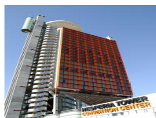
Fachada del hotel con Centro de Convenciones
